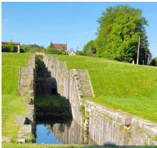
Les 7 écluses – (désaffectées)
