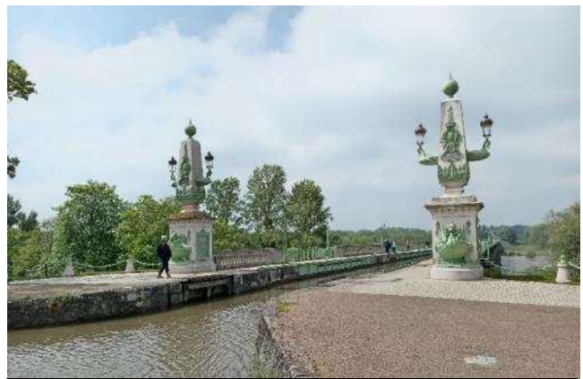
Entrée du pont canal
